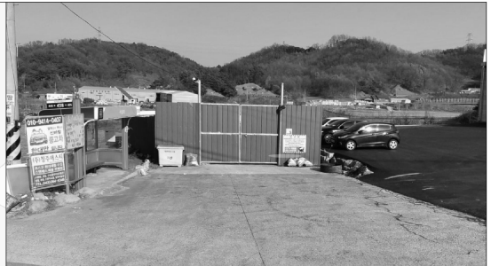
공동집하장 현장 사진(예시)
