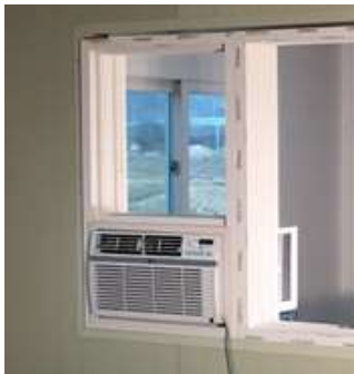
창호 일체형 에어컨 설치 예시
