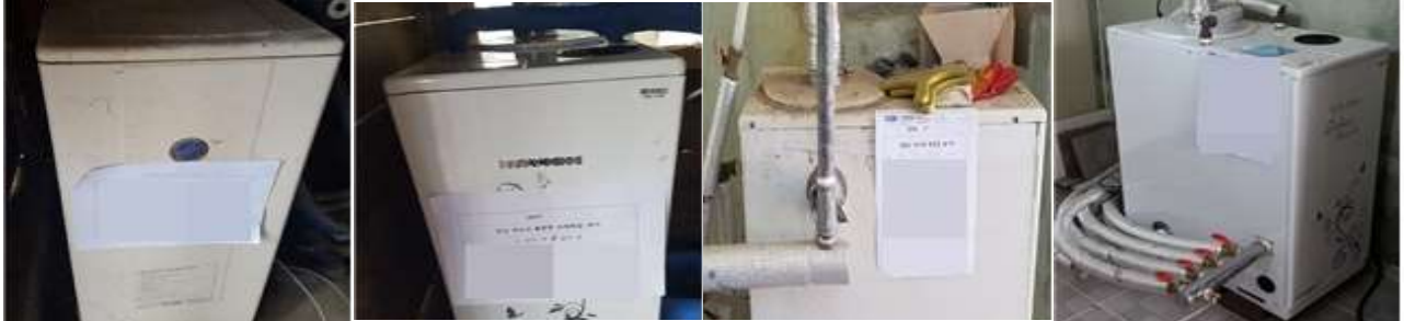
<기존 보일러 확인 → 보일러 철거 → 보일러 교체 설치> (왼쪽부터 가스보일러 시공 전/후, 기름보일러 시공 전/후)
