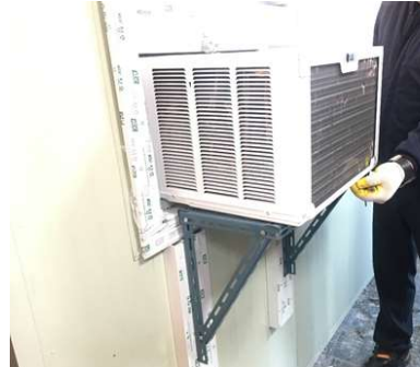
창호 일체형 에어컨 설치 예시
