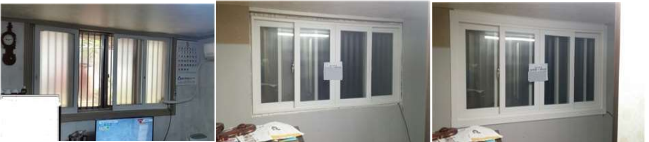
<창짝해체 → 신규틀시공 → 단열폼사춤 → 노출부마감>
