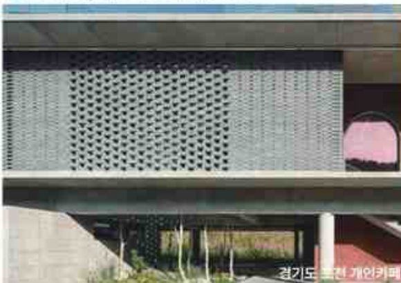
① 입면 분절, 외관 디자인 건축물 사례
