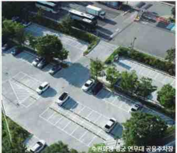
❸ 투수성 재료를 사용한 친환경 주차장 사례
