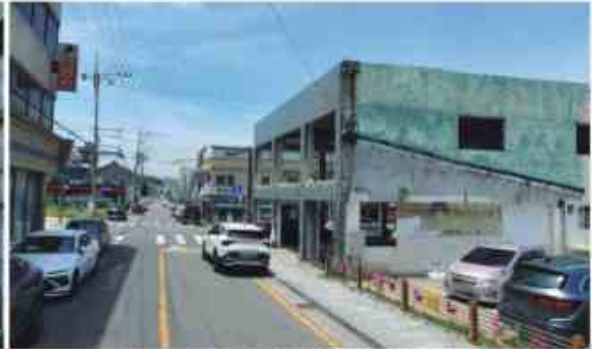
구도심 동령길에 위치한 방치된 폐건축물
