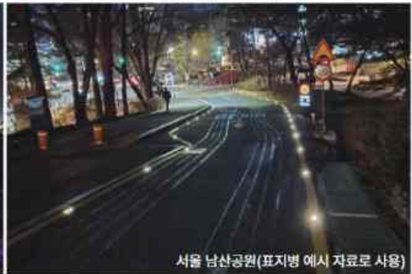
④ 도로 표지병 설치로 도로 경계부 시인성 확보 사례
