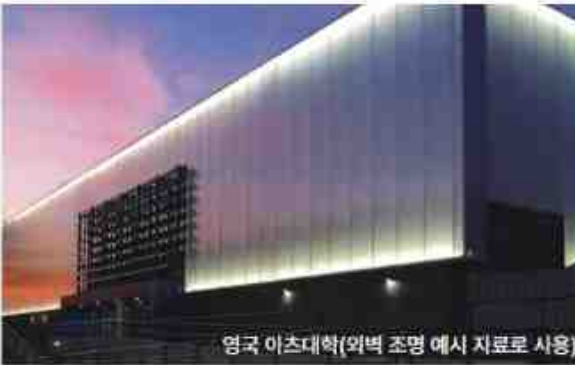
① 건축물 외벽 조명 적용 사례
