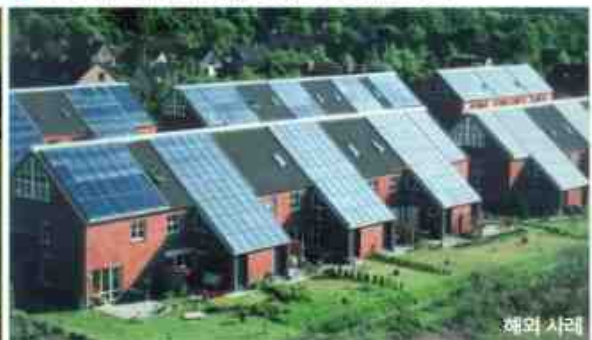
② 지붕 규모에 맞춰 태양광 시설을 설치한 사례
