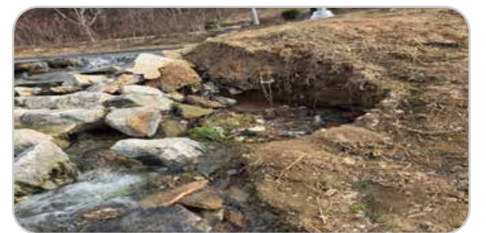
하천 제방 유실
