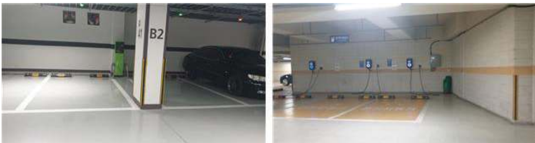
〈그림 34〉 충전구역 미표시(좌), 충전구역 표시기준과 다른 색상(우)
